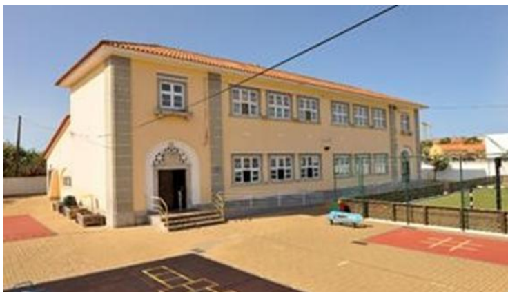
Figura 16 - Escola Básica de 1.º Ciclo de Ferrel – edifício 1
